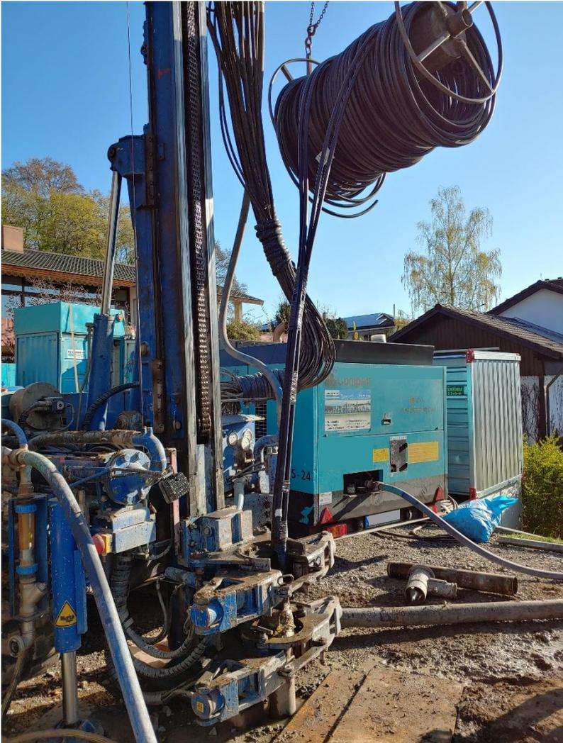
Einbau der Erdwärmesonde ins Bohrloch
